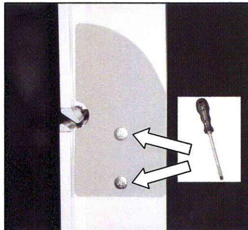
Schlupptür öffnen und Eingriffschutz an alle Übergänge zwischen den Sektionen der Tür anschrauben.
