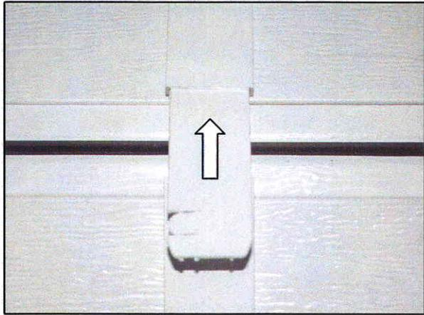
Tor leicht öffnen. Oberteil Fingerklemmschutz in Türfassung einschieben. Linke und Rechte Ausführung.
